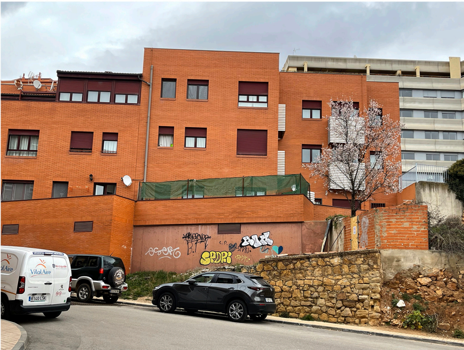
Actual acceso a la parcela mediante rampa. Esta zona se corresponde con espacio libre anexo al viario, es decir como un ensanche de la acera, según determinaciones del PGOU.
