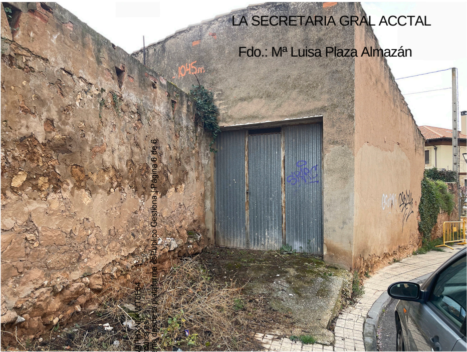
Imagen de la acera de el lindero frontal con una alineación real que no se corresponde a la del PGOU; en la que se supone que la línea del lindero frontal vendría hasta la arista de la edificación, anulando en ese caso su puerta de acceso.
