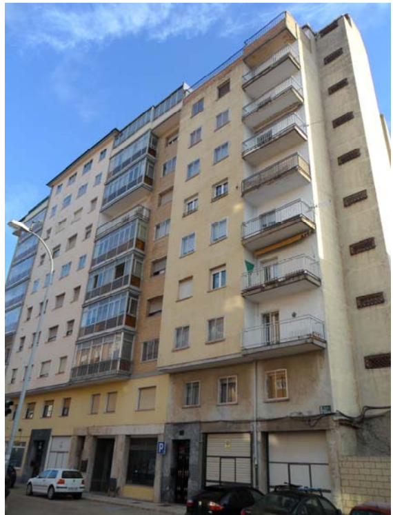
CALLE PUERTA DE NAJERA Nº 2 Y 4
