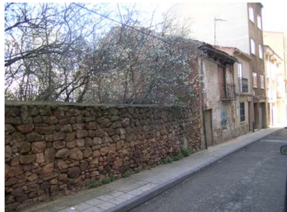
CALLE SAN MARTIN Nº 28
