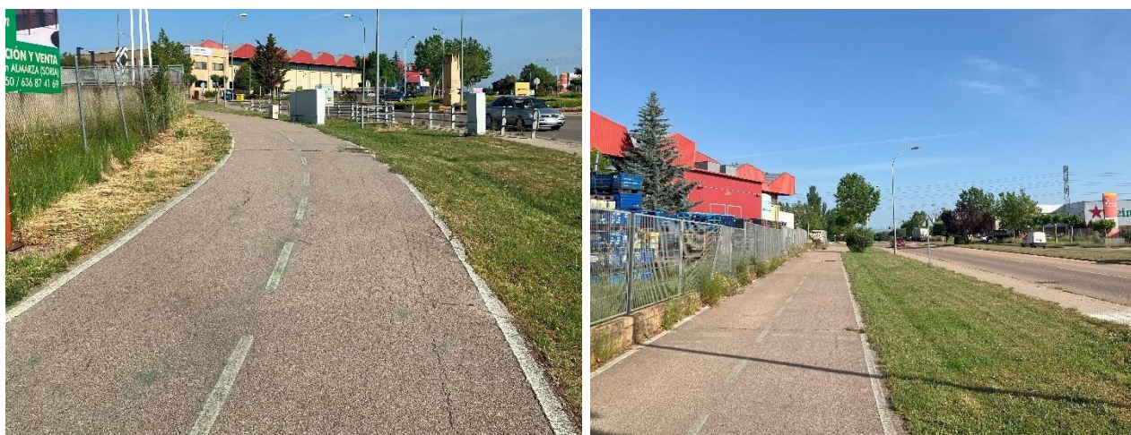
Foto 5: Vía ciclista a lo largo de la calle “A”
