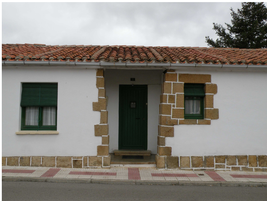
Vivienda tipo B con porche cubierto según construcción original (C/ Santa María de la Cabeza, 10)
