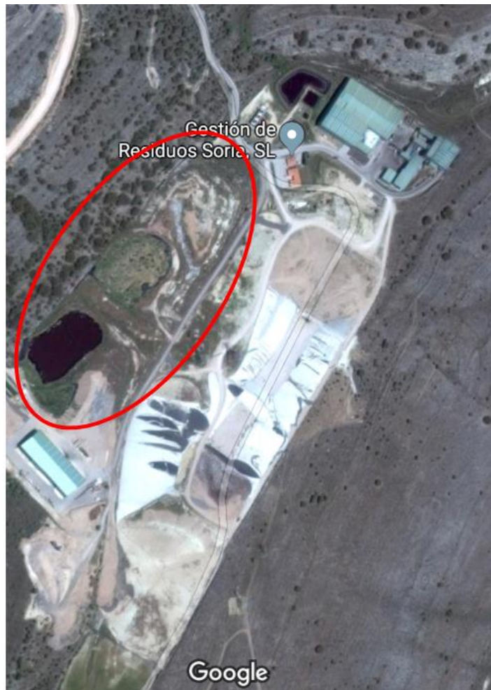
ILUSTRACIÓN 6. BALSAS DE LODOS EN LOS VASOS 1-2
