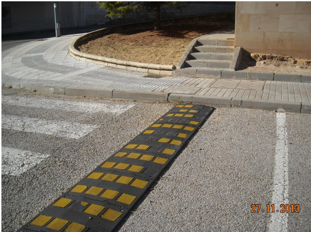
*Vista de la irregularidad superficial del pavimento el cual será necesario fresar. Será necesario desmontar parte del ralentizador de velocidad fijado a la calzada.*
