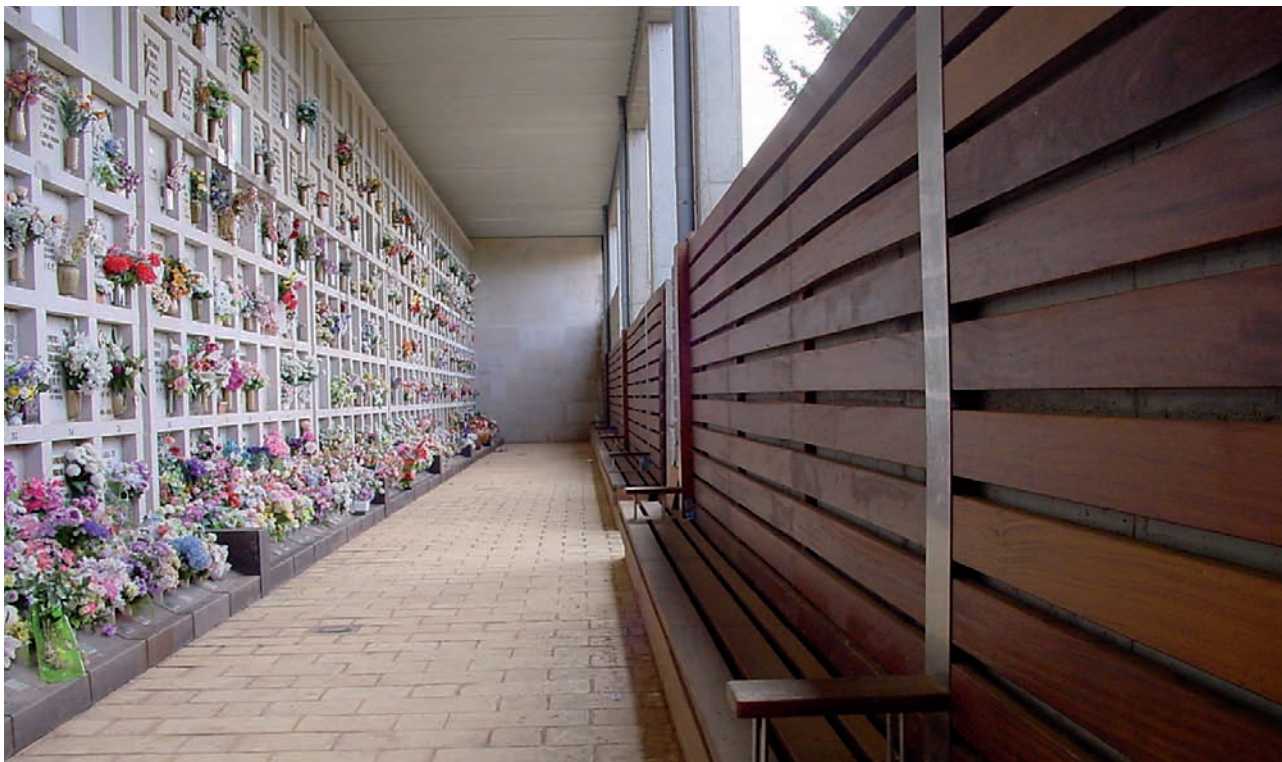
Edificio de nichos de siete pisos de altura
