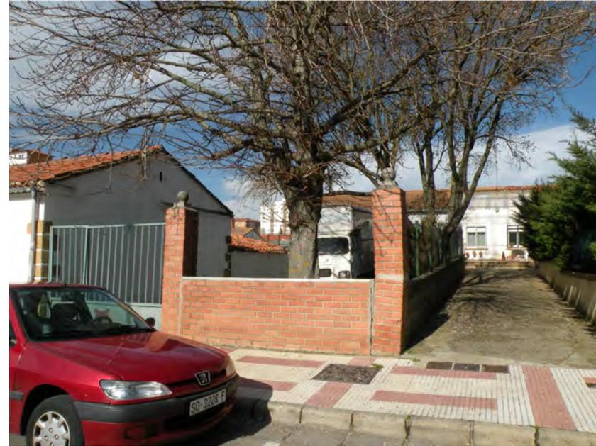
Supresión del vallado de madera original de parcela y sustitución por muro de bloque de hormigón visto.
